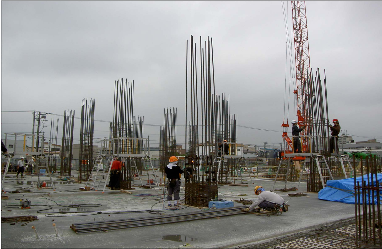
1 F 柱配筋・圧接状況
