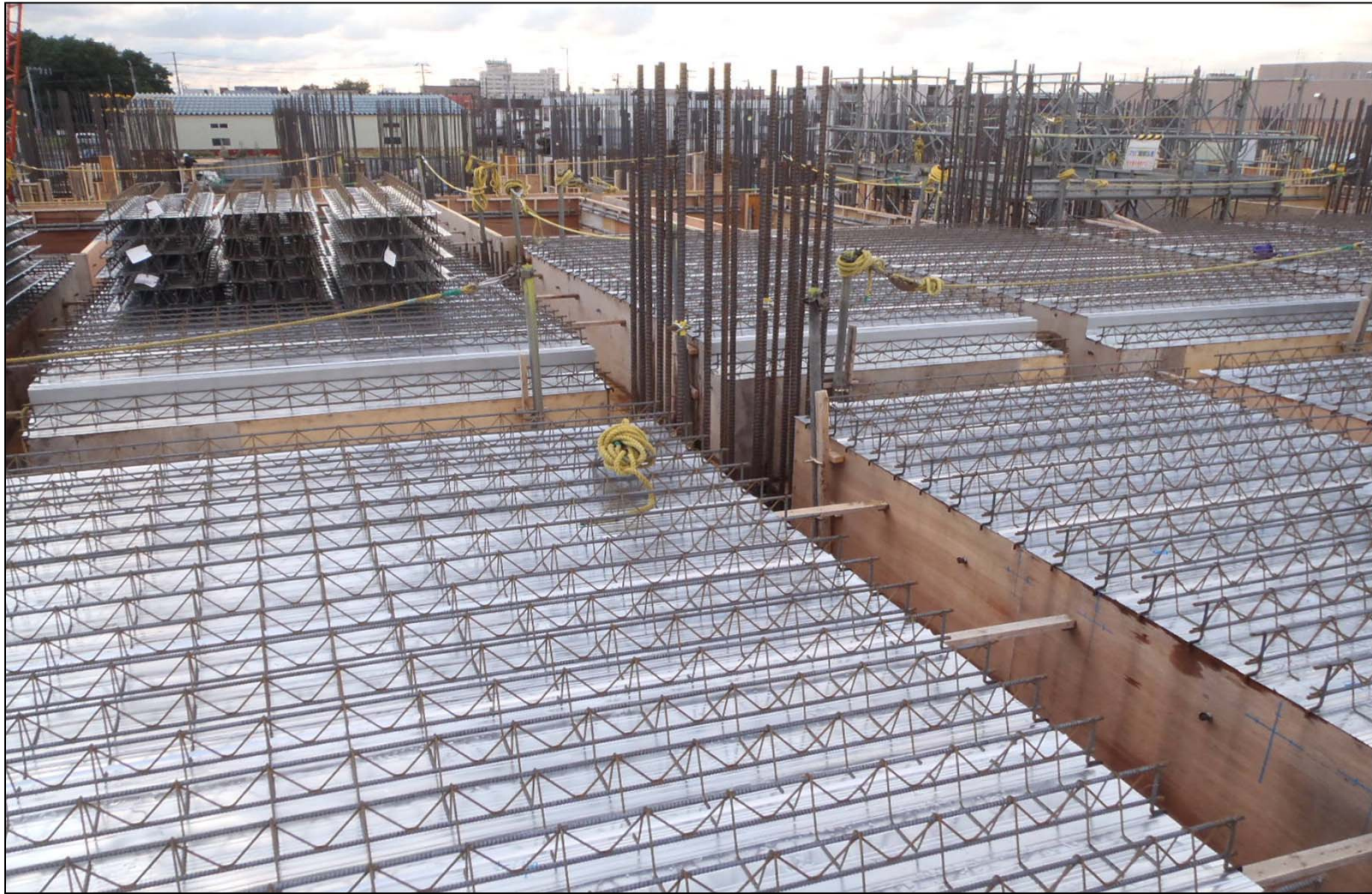
2Fスラブ型枠（フェローデッキ）
