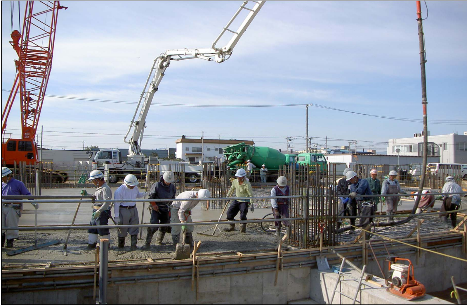
1 F 床コンクリート打設状況
