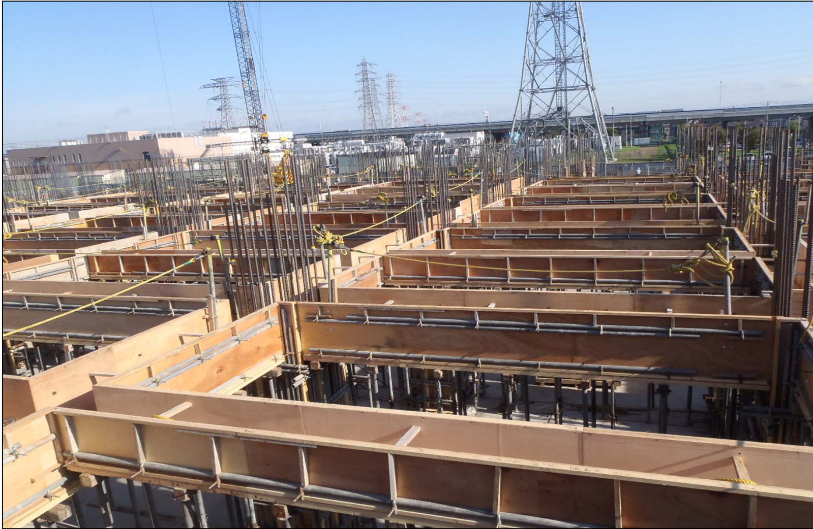
2 F 梁型樁建込み状況
