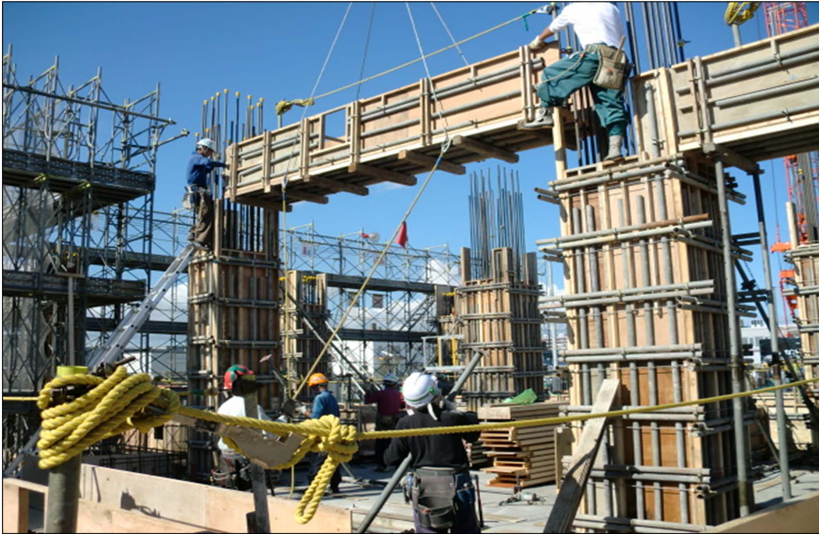
2 F 梁型樁建込み状況
