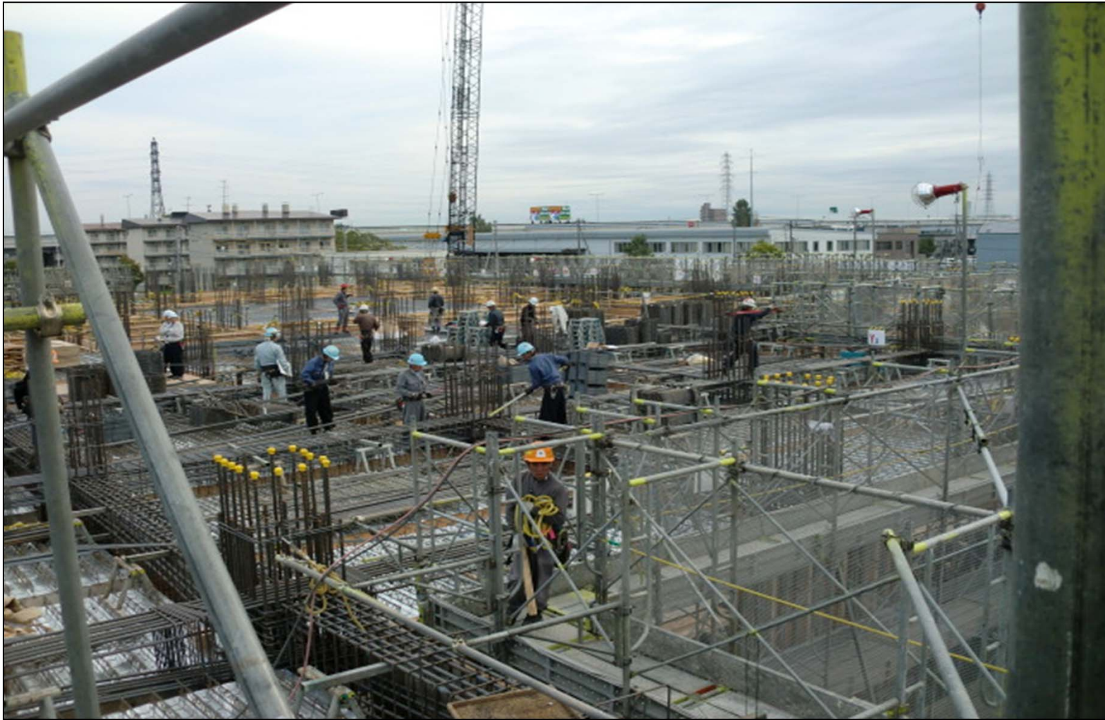
2 F 梁配筋状況
